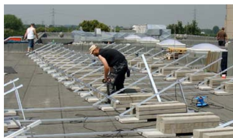
Anlage auf dem Bildungspark Essen im Bau
