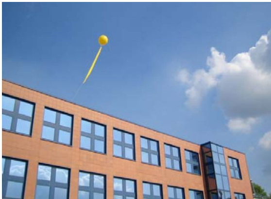
Unser Dach auf dem Gebäude der Jugendhilfe im Sommer
