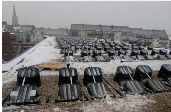
Die Unterkonstruktion konnte noch vor dem Schnee montiert werden – hier die ersten Flocken am 16. Dezember 2010
