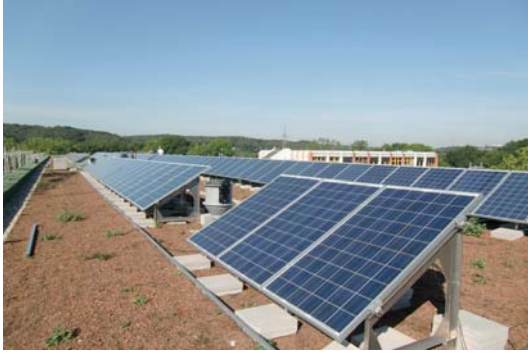
Gymnasium Überruhr – auf dem Dach
