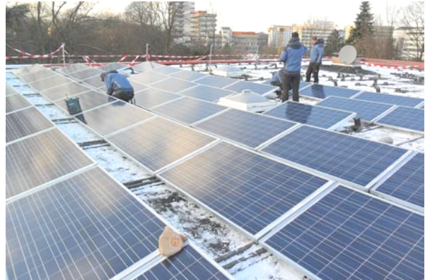
Gruga, „Schule Natur“: Montagearbeiten bei Eis und Schnee
